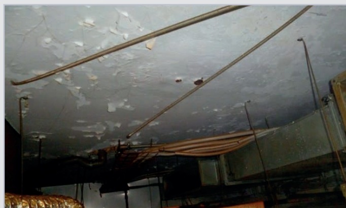
OTEVŘENÝ SYSTÉM – STROPNÍ DUTINA PO JEDNOM ROCE PROVOZU
