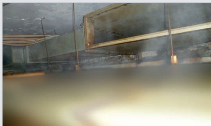
OTEVŘENÝ SYSTÉM – STROPNÍ DUTINA PO JEDNOM ROCE PROVOZU
