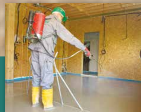
Jak na litou podlahu v dřevostavbě
